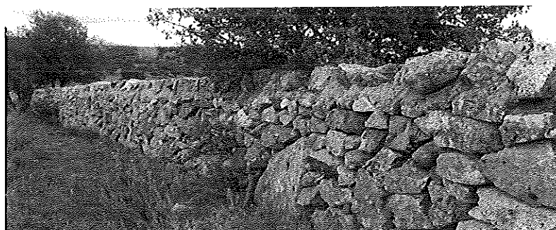
Ejemplo de muro de piedra seca con cementación en la primera línea en Colmenar Viejo.
